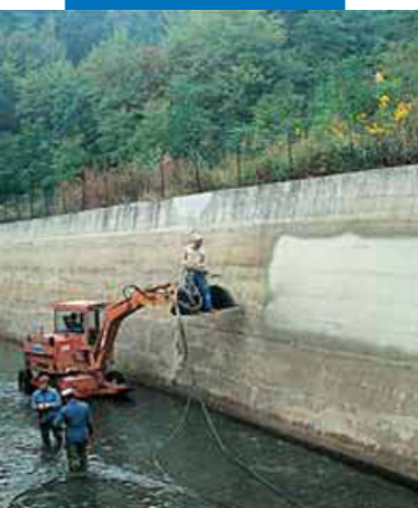
Нанесение Planiseal 88 напылением на подводный канал гидроэлектростанции
