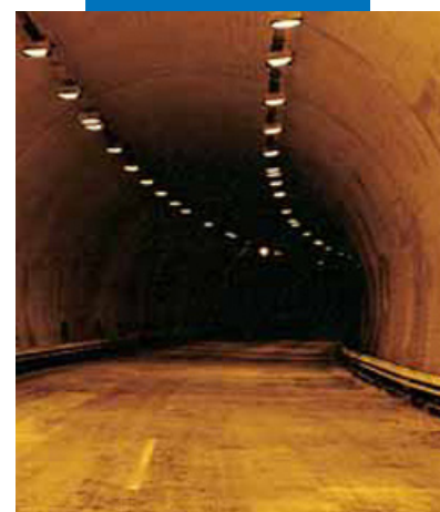
Нанесение белого Planiseal 88 напылением в автодорожной галерее
