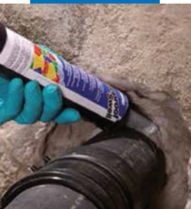
Нанесение Мареproof Swell вокруг трубы
