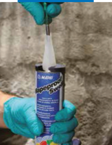
Прокалывание защитной мембраны на тубике Мареproof Swell
