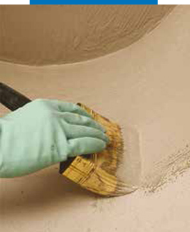
Нанесение гидроизоляции с помощью кисти
