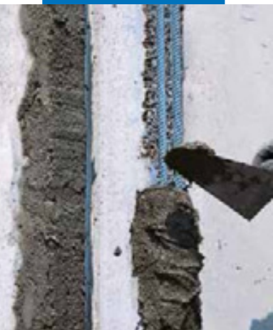
Нанесение раствора мастерком
