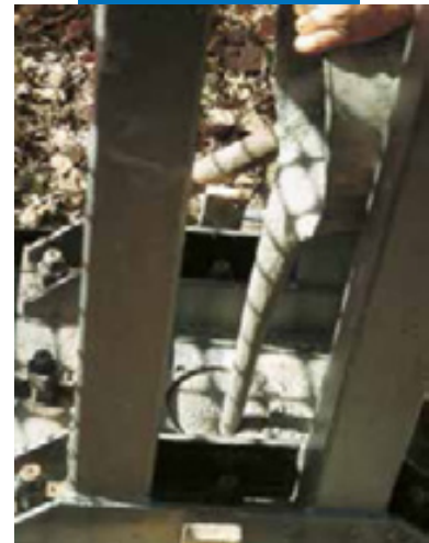
Анкерное крепление с помощью раствора Mapefill
