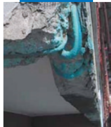
Арматура на балконе, обработанная Mapefer 1K
