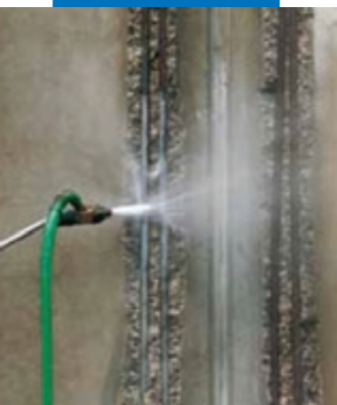
Очистка стальной арматуры
