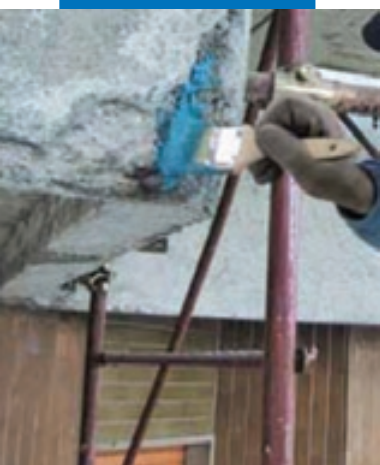
Нанесение Mapefer 1K кистью на арматуру балкона
